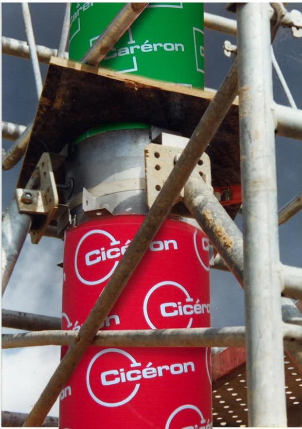
**BRIDECO** se compose d'un feillard galvanisé de 200 mm de large, d'une sangle avec tendeur à cliquet, et de trois ou quatre cornières percées (« oreilles »). Ces oreilles facilitent la fixation :
